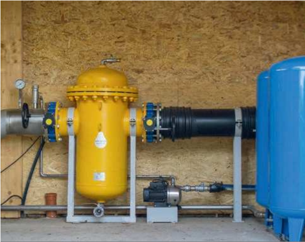
Vor den Pumpen befindet sich nun ein Schlammabscheider SpiroTrap, der explizit für den Golfpark konstruiert wurde. Rechts sind die Expansionsgefäße zu erkennen.
